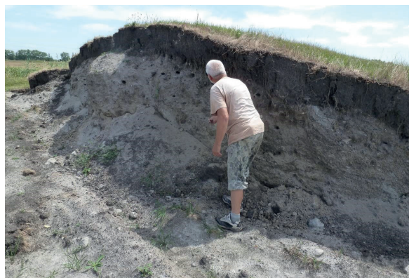
Obr. 3.96. Prierez hrádze Komárňanského kanála na JZ od Štúrovej (Okoličná na Ostrove). Násyp kanála pozostáva z autochtónneho materiálu piesčitých štrkov ťažených bagrovaním kanála (foto J. Maglay, 2016).
