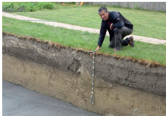
Obr. 3.60. Výkop základovej jamy v siltach až piesčitých siltach „jadra“ Žitného ostrova na V od Samorína v Šamote (foto J. Maglay, 2015).
